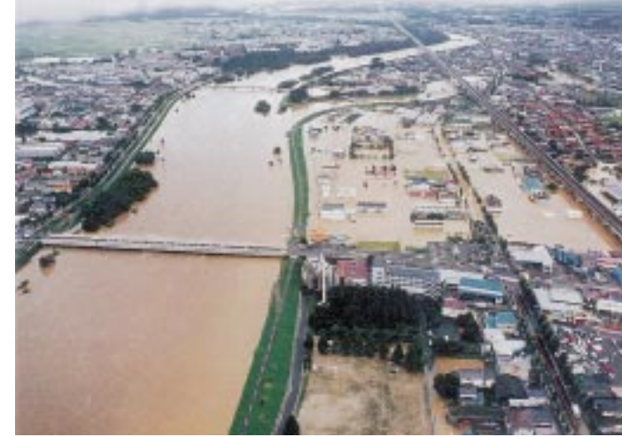
写真7 笹原川合流点左岸側の氾濫状況（福島工事事務所提供） Photo 7 Flooded area at the left side of the confluence of the Abukuma River with the Sasahara River.
