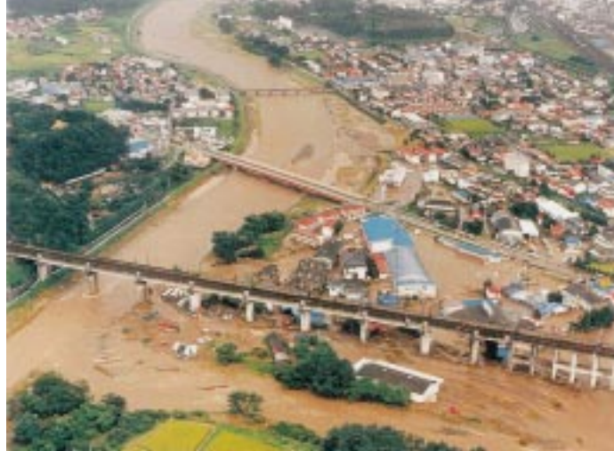
写真10 白河市堀川合流点の氾濫状況（福島工事事務所提供）
