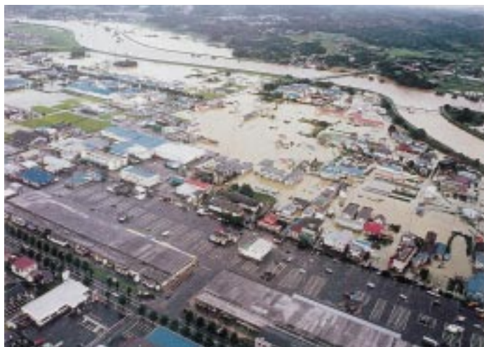
写真6 逢瀬川合流点左岸側の氾濫状況（福島工事事務所提供） Photo 6 Flooded area at the left side of the confluence of the Abukuma River with the Ohse River.
