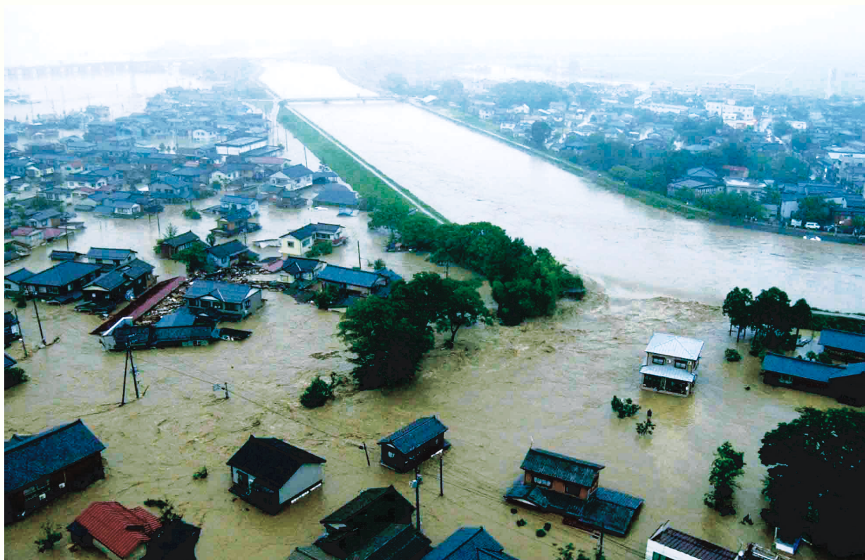
刈谷田川の堤防（中央右）が決壊し水浸しになった新潟県中之島町（手前）。川向こうは見附市。 (2004年7月13日午後6時11分、共同通信社ヘリから撮影：共同通信社提供)
