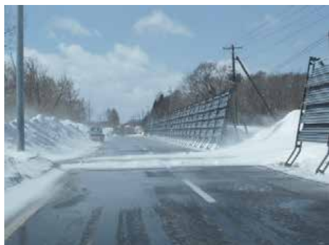
図6 道路上に形成された局所的な吹きだまりの様子 (2014年4月11日, 中標津町郊外).
