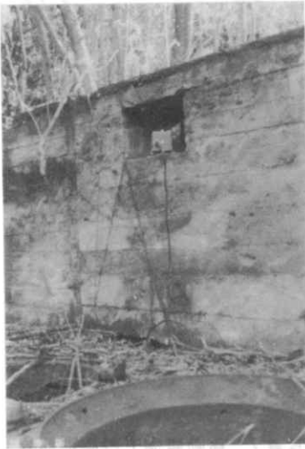
写真2 南方空炊事場跡の壁の銃眼?に地震計を設置した。
