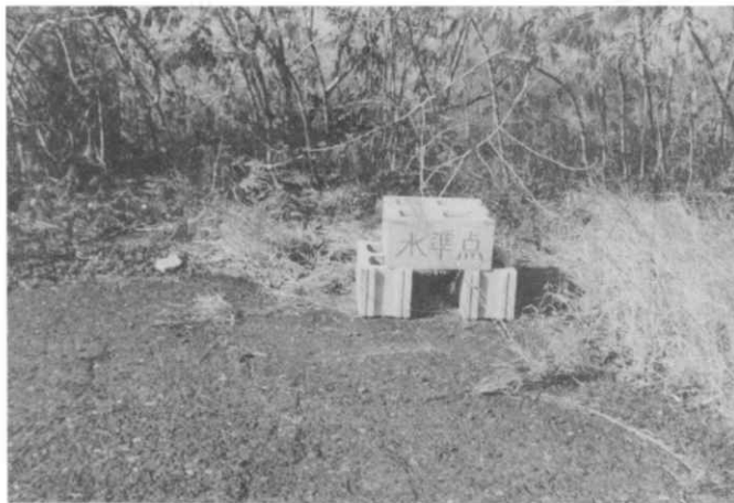
写真4 水準点・設置機関不明ではあるが、後日のために保護石を積む(阿蘇台断層の南約200mの十字路)
