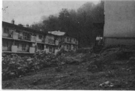
写真1 断層の垂直変動により折れ曲がった洞爺マンション
