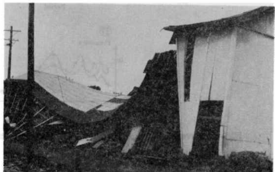
写真—2 大山 ⑰ 振動による家屋の倒壊 Fallen houses by vibration.
