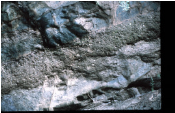
柳久保池 善光寺地震被害
