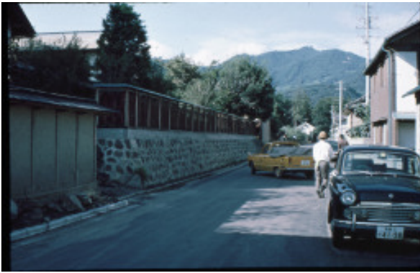
小松原の断層 善光寺地震被害
