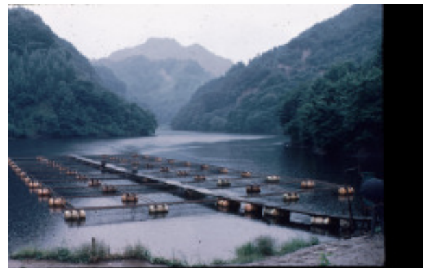
柳久保池 善光寺地震被害
