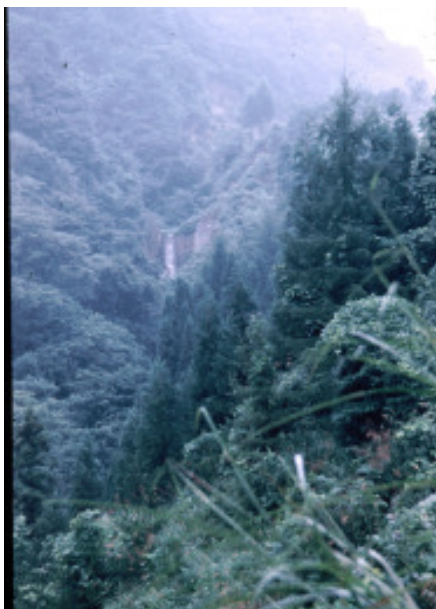
柳久保池 善光寺地震被害
