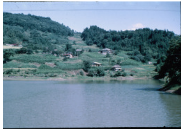
浦池 善光寺地震被害
