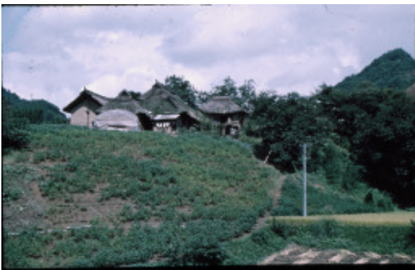
柳久保池 善光寺地震被害
