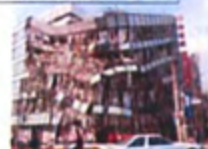
壊れないと思っていたビルが倒壊
