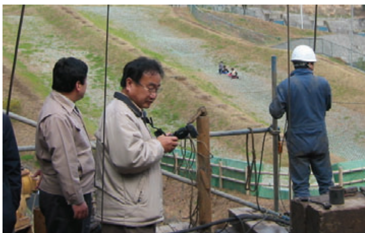
大深度ボーリング調査(2004年3月, 山北町)
