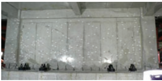
(3) 1 層 X_2Y_{2,3} 耐震壁(加振 6 後) 写真3 加振終了時の破壊状況
