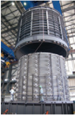
写真5 真空飽和用の蓋の設置状況
