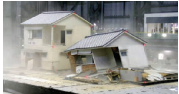
写真1 加振後の様子(右:無補強建物、左:耐震補強建物)
