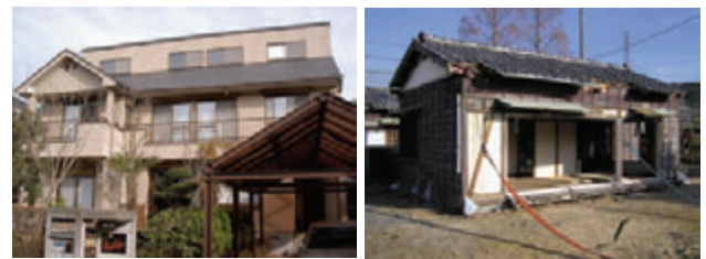
写真 1 地震応答観測対象建物例 写真 2 劣化と耐震性調査建物
