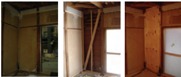
写真5 B棟耐震補強(左から、補強前、筋かい、合板)
