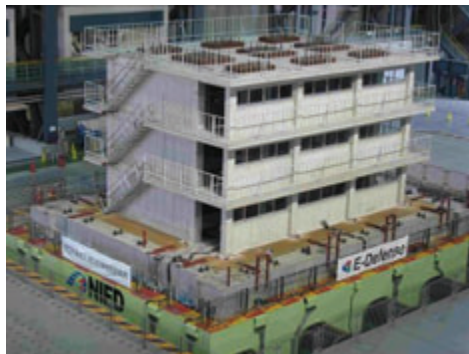
写真4 既存RC試験体 概観
