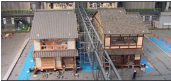
新築京町家試験体 移築京町家試験体 写真3 京町家の震動台実験
