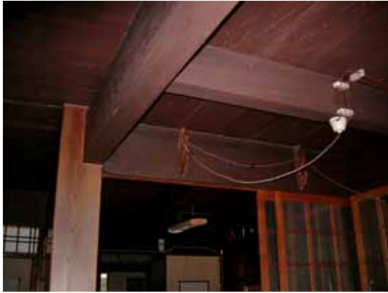
写真3 大黒柱と差鴨居（厚鴨居）
