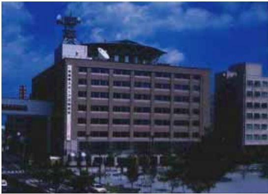
写真2 青森県災害対策本部室（青森県庁舎北棟）
