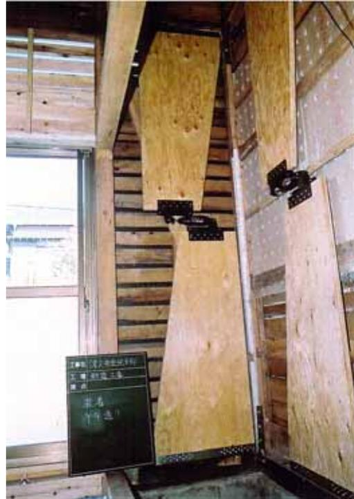
制震ダンパーによる耐震補強
