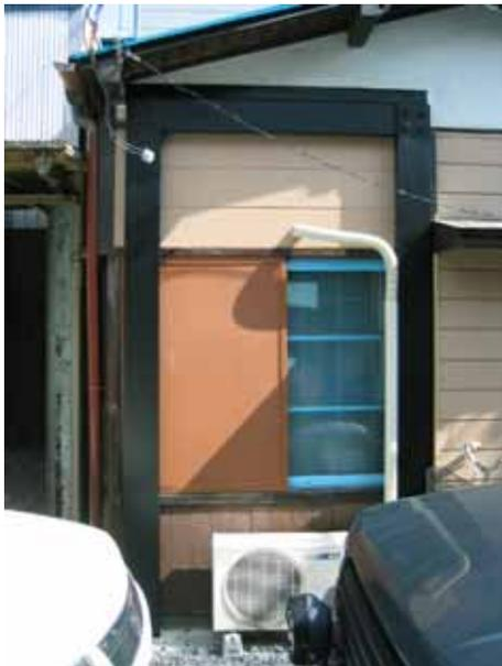
写真3 アルミニウム耐震補強枠
