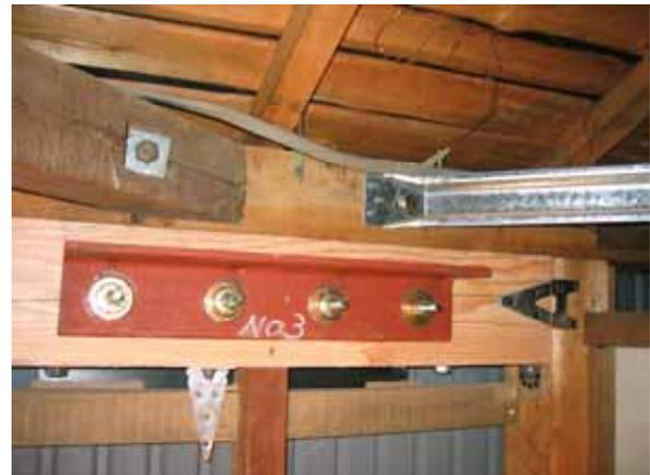
写真6 耐震ポール内部接合部分
