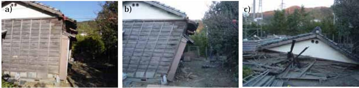
写真 7 建物 No.6 の倒壊状況
