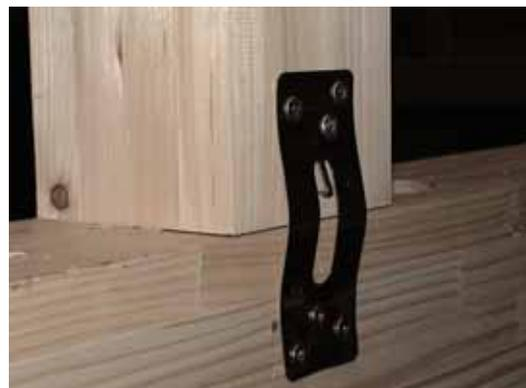
写真 6 一般部の仕口金物の損傷
