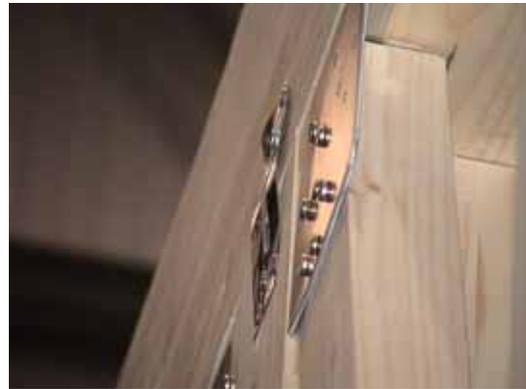
写真 4 柱と筋交いの取り付け部の金物の損傷
