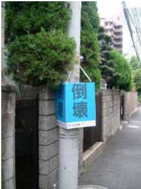
倒壊看板（45箇所）
