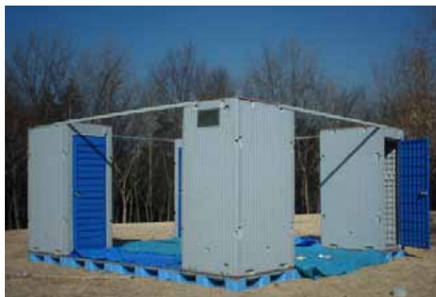
図 15 試作住宅施工中の写真
