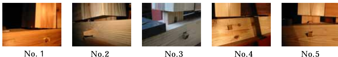
写真3 破壊時柱脚部の状況
