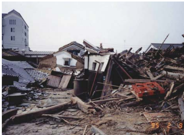
写真2 崩壊した古酒蔵(95年2月9日撮影)
