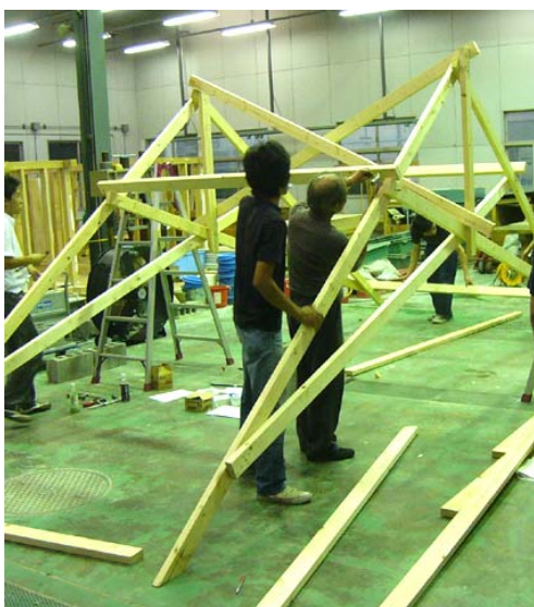
図 12 屋根架構の組み立て
