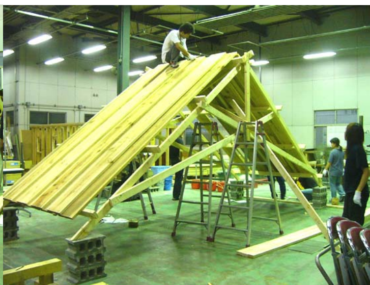
図 13 組み立て終了段階の試作実験
