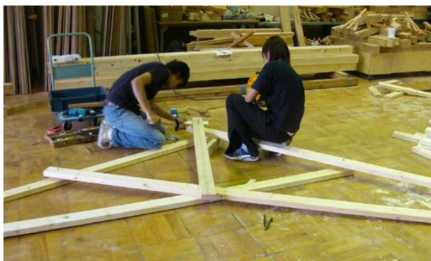
図 9 シザーズトラスの製作
