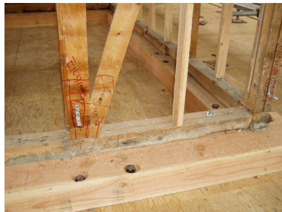
写真 22 移築中土台
