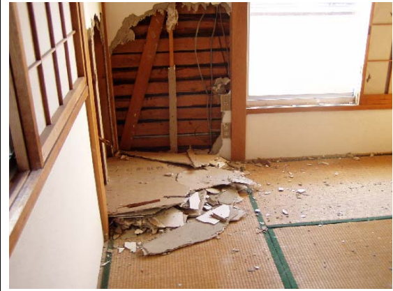
写真 8 内壁下地 和室 (木ずり)
