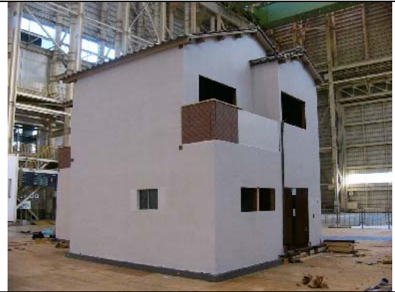
写真 26 移築後試験体 南西面
