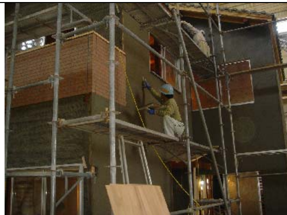
写真 24 モルタル塗り
