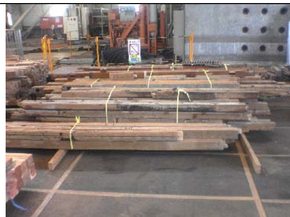
写真 16 解体された軸組
