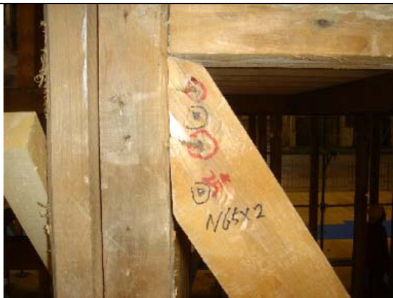
写真 23 移築中 筋かい接合部
