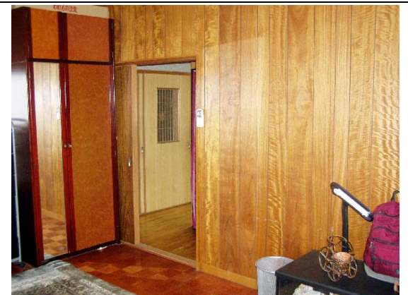
写真 6 内壁仕上げ (プリント合板)
