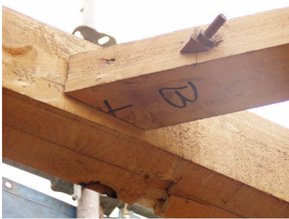
写真 9 小屋梁-火打ち梁接合部
