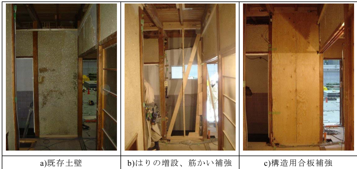
写真 36 補強の過程
