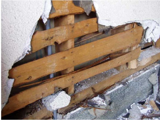
写真 7 外壁下地 (木ずり)
