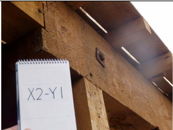
写真 11 柱-梁接合部
