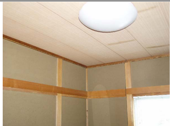
写真 5 内壁仕上げ (モルタル)
