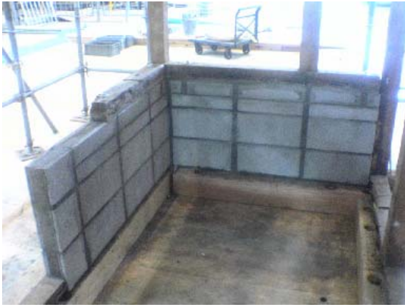
写真 33 ブロック基礎部分
