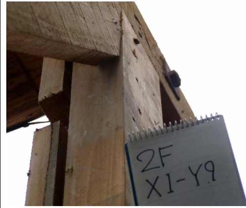
写真 10 柱-梁接合部
