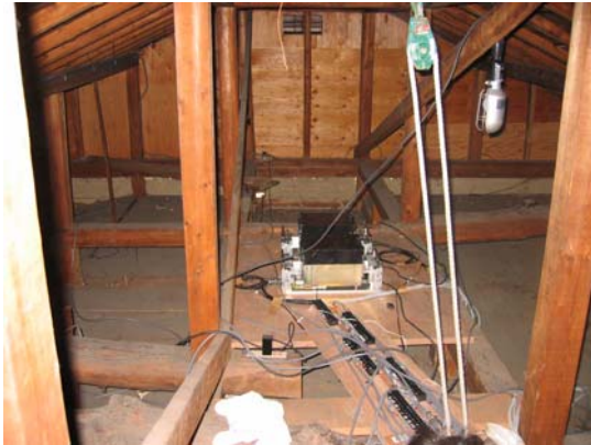
写真2 屋根裏に設置した加振機
