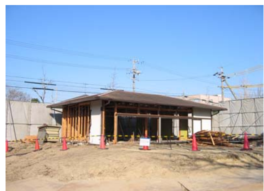
解体途中の試験体。雑壁と構造壁の一部が撤去済みである。
