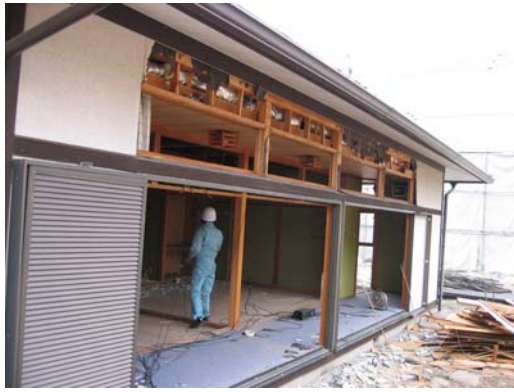
写真 4 雑壁撤去の様子(Case2)
