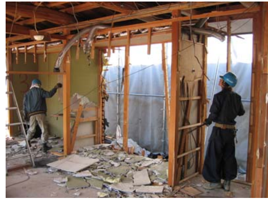
写真 5 耐震壁撤去の様子(Case3)
