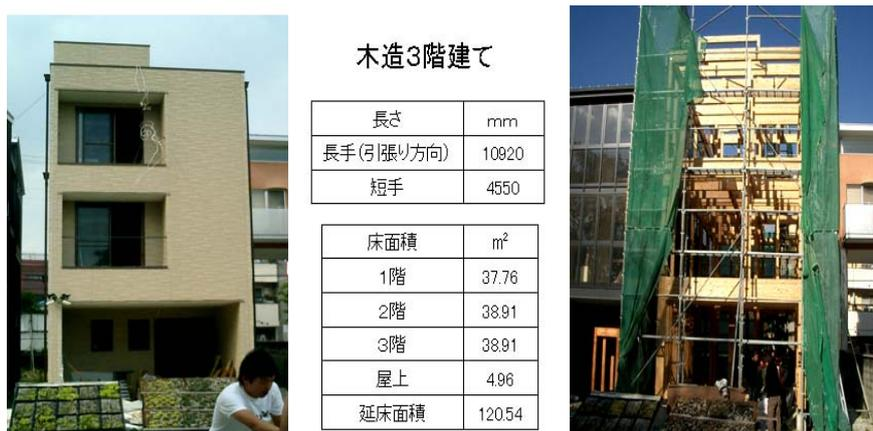
図16 設計仕様（左図健全時、右図骨組み時）
