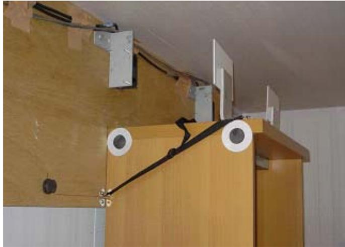
図7 ベルト式 (30° 下取り付け)
