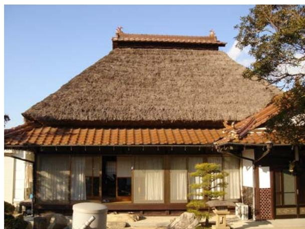
写真 4 軒先のみ瓦葺きの茅葺き住宅（伊藤撮影）
