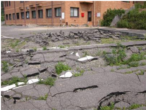
図 44 旧山古志村役場前駐車場の様子
