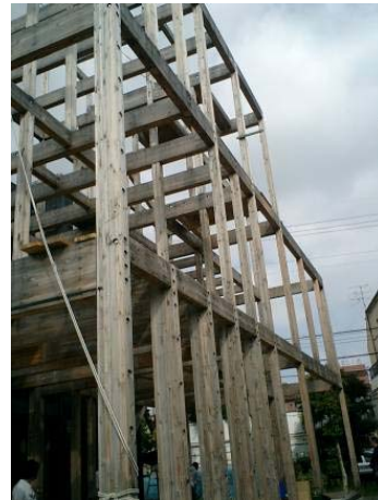
(13) 13 段階 2 階ブレース撤去 2006 年 10 月 18 日
