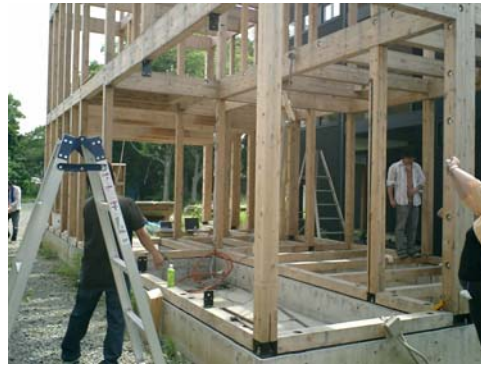
(2) 2段階 1階柱撤去 2006年5月31日
