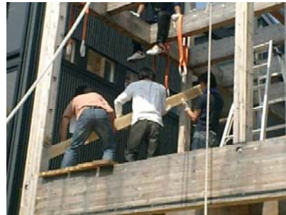
(13) 13 段階 2 階ブレース撤去 2006 年 10 月 18 日
