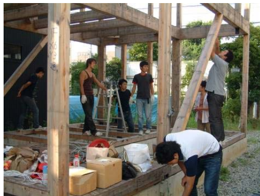
(6) 6段階 1階ブレース北側撤去 2006年9月27日
