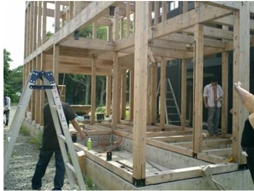
(7) 7段階 1階ブレース両側撤去 2006年9月27日
