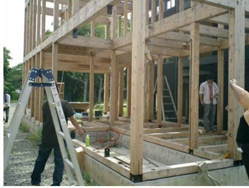
(4) 4段階 1階ブレース撤去 2006年6月21日
