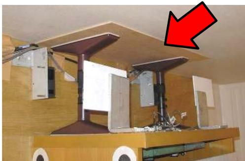
図 8 「ポール式+合板材」転倒防止器具
