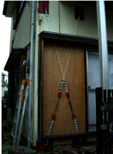
図 10 後付ブレース施工例 (平塚耐震補強推進協議会WEBより)
