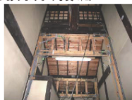
写真2 吹抜にはしご型フレームで補強した例
