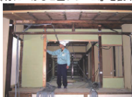
写真1 開口を乾式土壁パネルで補強した例
