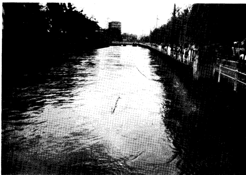
写真－２４．坪井川厩橋下流側の状況
