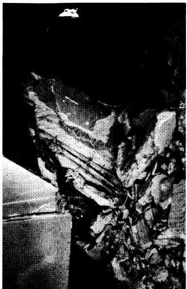
写真11 ショールームと事務室との間にある通行路に面する側面。1階は完全につぶれ、2階が1階となる。このため、ショールームにつながる設備配管が大きく曲る。
