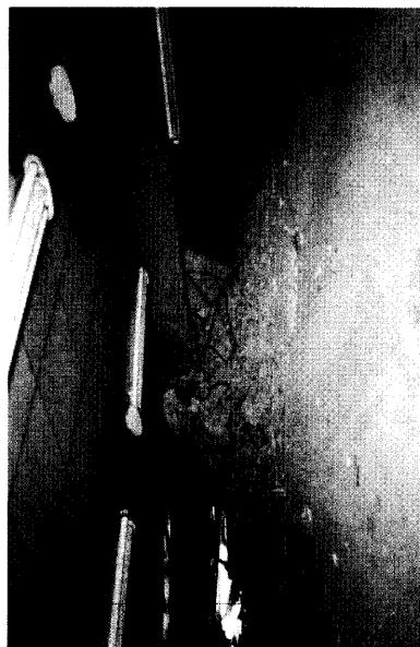
写真 6 崩壊した1階柱、フープ間隔があらい
