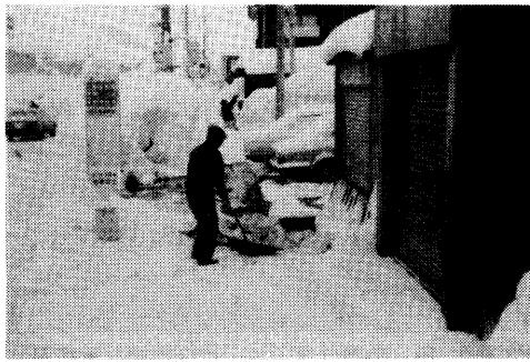
写真 2. 32 下水溝も上手に利用してミニ流雪
