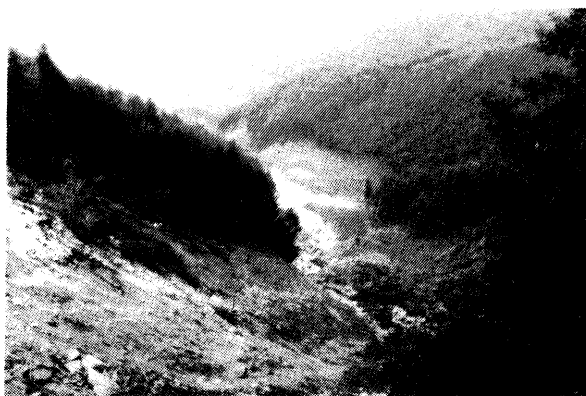
写真19 崩壊地からみた宇原川上流付近
