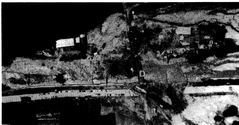
写真32 鮎川，大門橋付近における氾濫および流木堆積の状況（8月25日 長野県警撮影）．流失をまぬがれた大門橋(D)には多量の流木がからまり，水位がせき上げられて低位面上の強い氾濫流が生じた．
