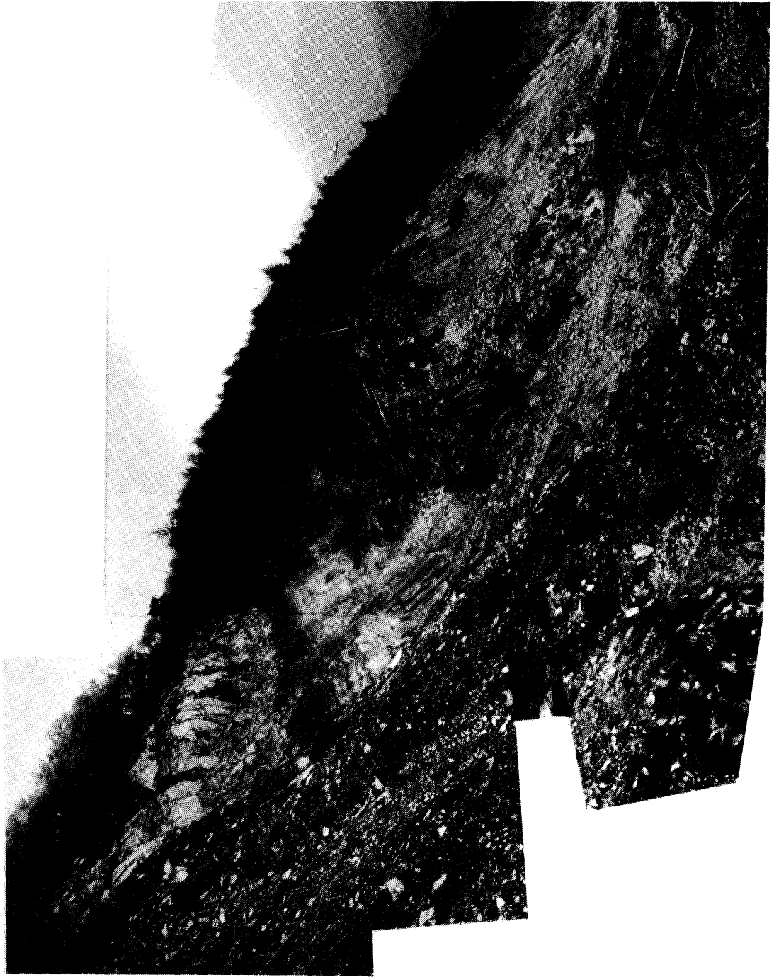
写真1 Aブロックより見た崩壊地
