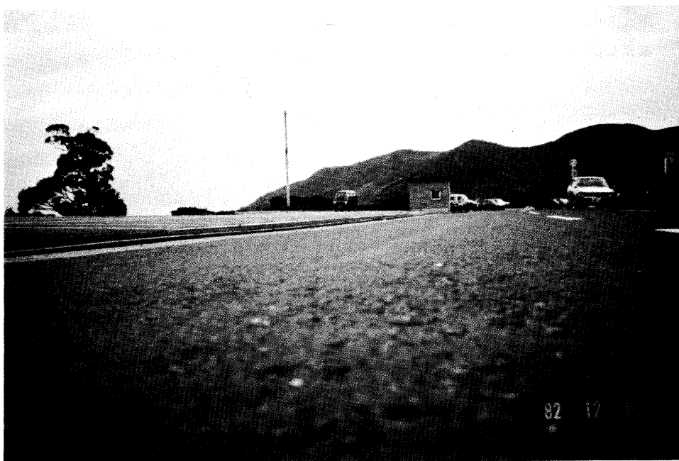
写真 5.23 卸団地盛土部の境界，境界端に向けて高くなっている 1982 年 12 月 6 日撮影
