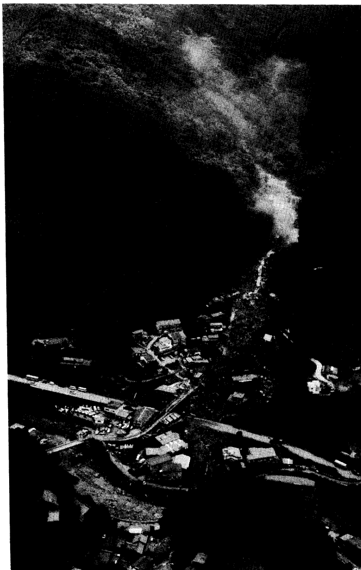
写真 5.1 川平地区被災状況 1982 年 7 月撮影 ナガサキ・フォード・サービス提供
