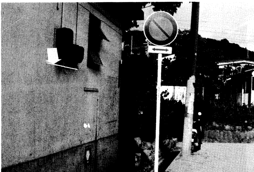
写真 6.5 洪水痕跡（長崎本線浦上駅より北へ50m，浸水深道上1.82 m，T. P. + 3.94 m） 1982年8月6日撮影
