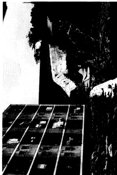
写真 6. 17 中島川上流の本河内低部水源池（明治 37 年 3 月完成）と本河内低部水源池の余水吐の被災状況
