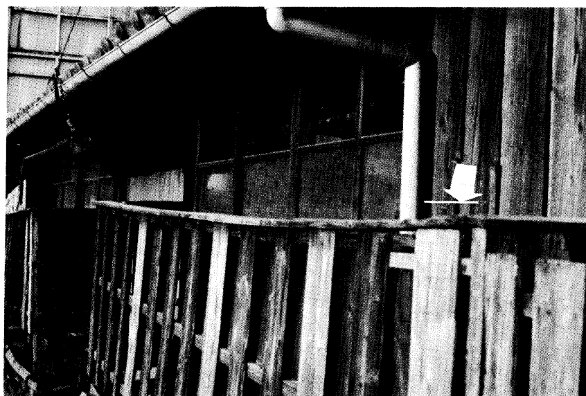
写真6.4 洪水痕跡（城山町城山小学校より北200 m浦上川沿い，浸水深道上1.7 m，T. P. + 6.8 m） 1982年8月6日撮影
