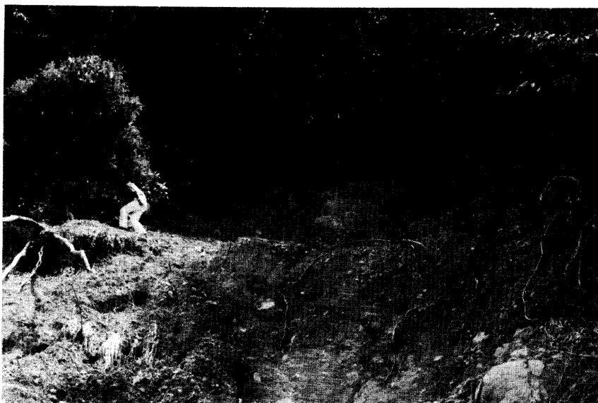
写真 5.19 戸町3丁目崩壊Bの崩壊源 1982年8月7日撮影
