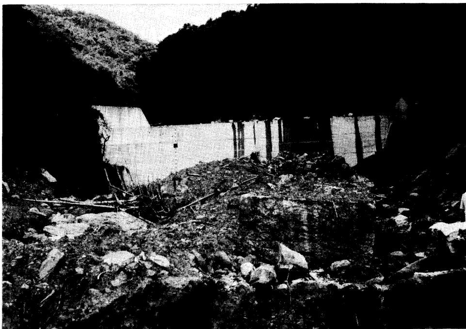
写真 5.3 袖部を破壊された第 3 ダム（川平地区）1982 年 8 月 5 日撮影
