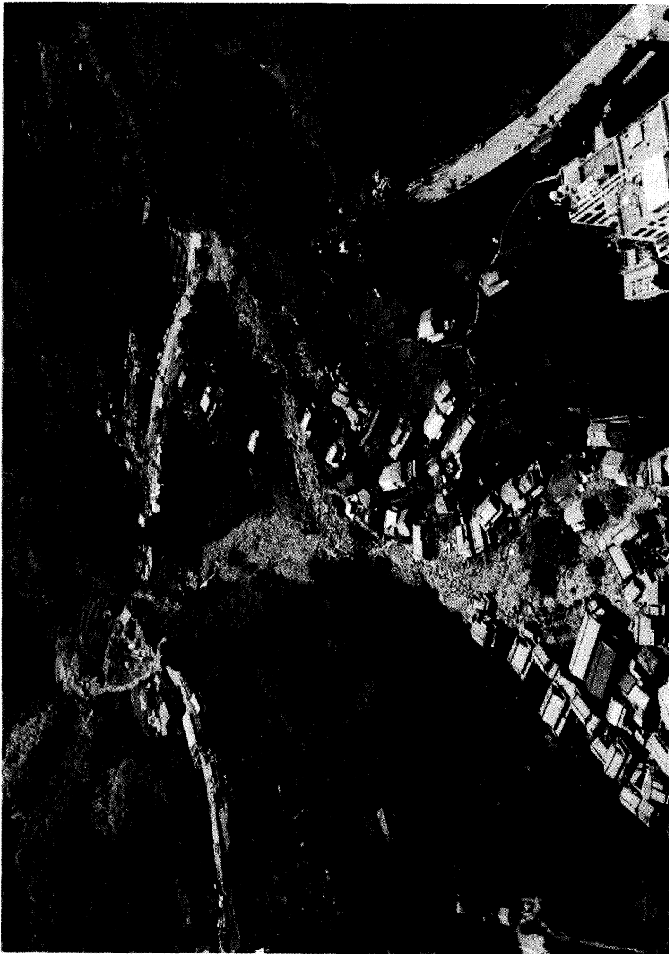
写真 5.20 芒塚地区の崩壊と土石流による被災状況 1982年7月撮影 ナガサキ・フォト・サービス提供
