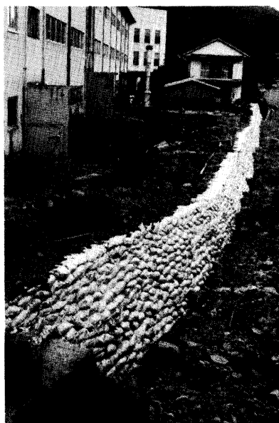
浦上川沿いの裏門付近 (②地点)
