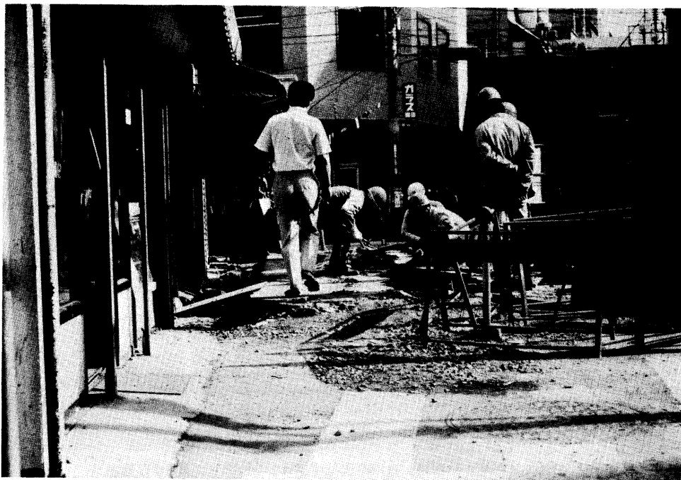
写真6.7 銅座川の暗きょが洪水により15cm程浮上している(思案橋付近) 1982年8月6日撮影
