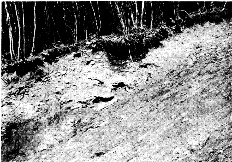
写真 5.12 奥山崩壊源に見られた穴 1983年3月14日撮影
