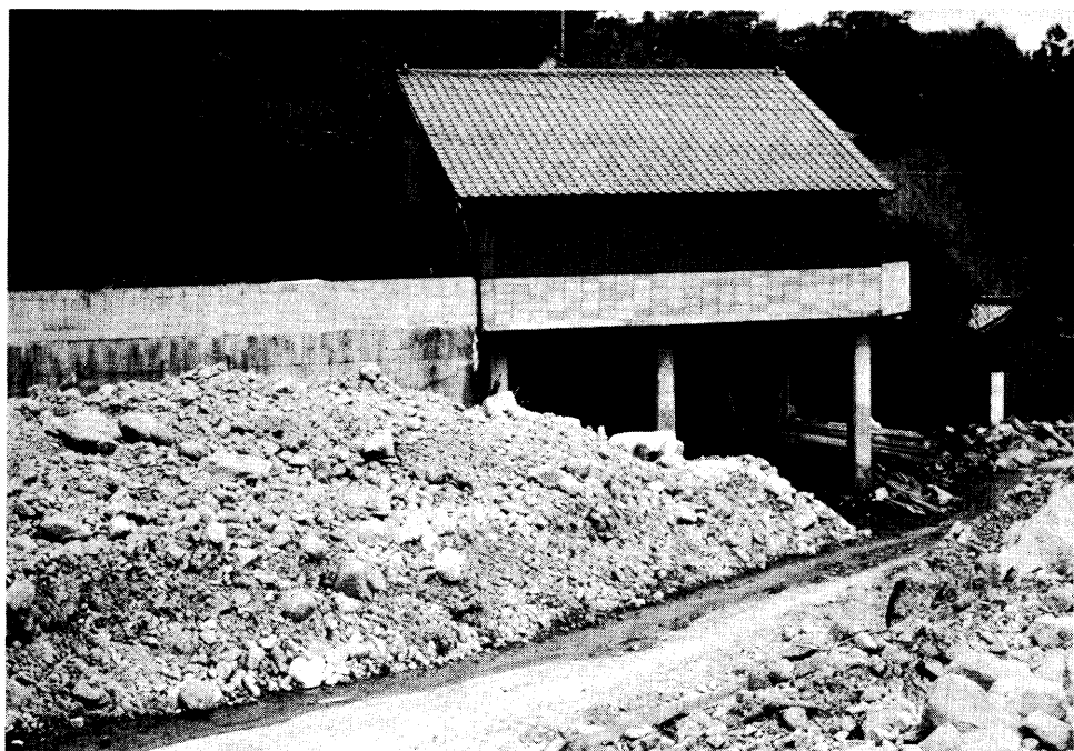
写真 5.7 被災をまぬがれたピロティ風の住宅（陣の内） 1982年8月4日撮影
