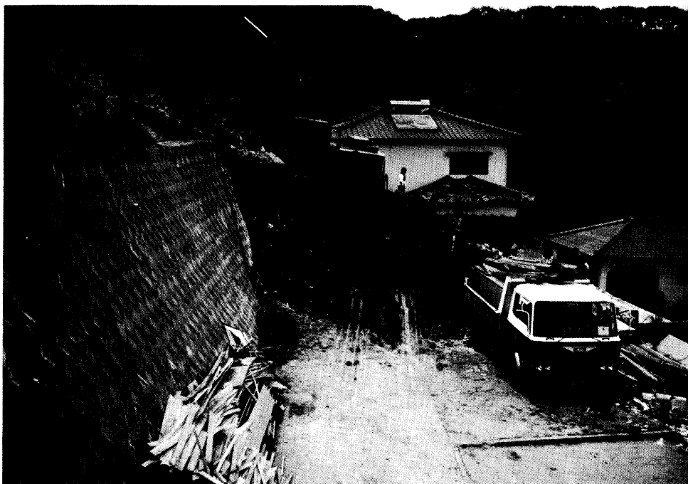
写真 5. 24 西高田地区のミニ造成地の崩壊 1982 年 8 月 6 日撮影
