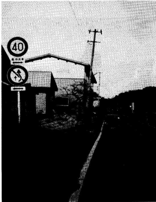
写真 4. 46 青森県西津軽郡鯉ヶ沢町浜毛付近, ブロック塀が倒れ, 側溝と道路間にすき間が見える.
