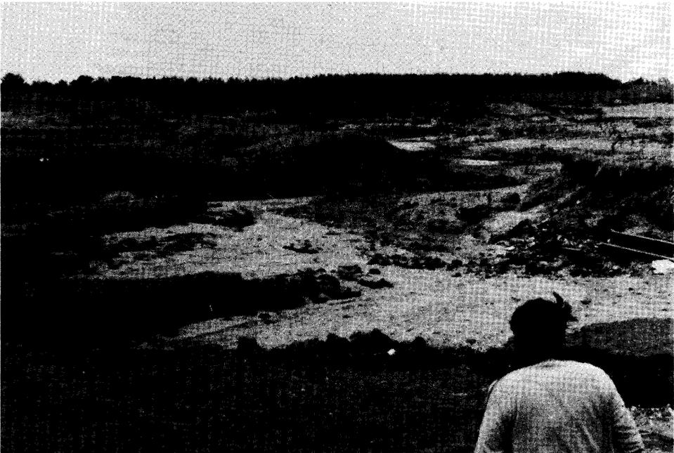
写真 5.24 上の写真の農道をまっすぐ進んで埸川河口の土堤にぶつかった地点. 戻り潮による田と土堤の侵食が著しい. 6 月 15 日 11 時ごろ撮影.
