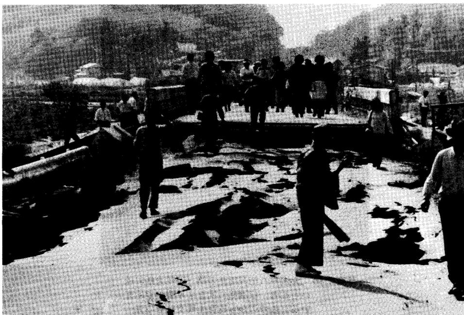
写真 4.20 大瀉村五明光橋 大瀉村側から五明光側に向かって見る. 橋取付部の路面沈下は約 50 ~ 60 cm ぐらいか.
