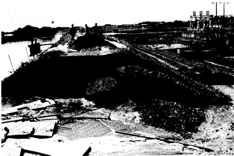
写真4.17 裏法面も崩壊
