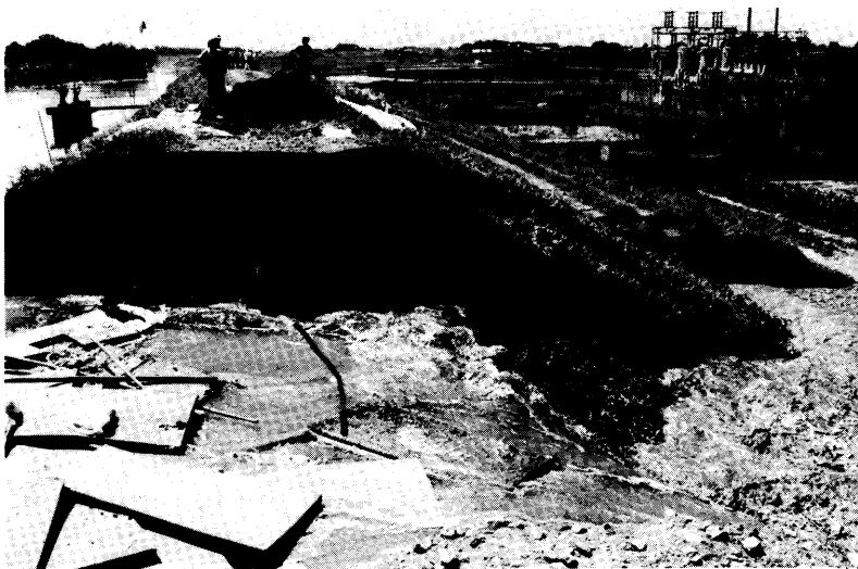
写真4.18 破堤時（破堤幅 7 ～10 m）
