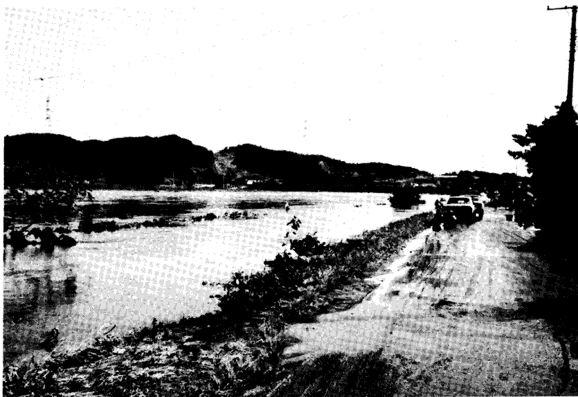
写真4.9 8月5日15時頃 二宮町，三谷の下流小貝川右岸より水戸部橋を望む
