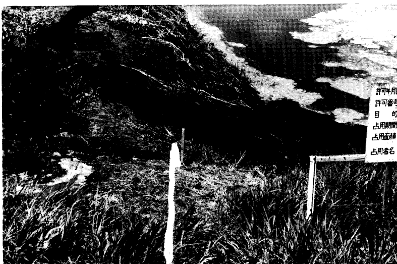
写真4.14 漏水箇所からの漏水量の増加（右側の水面は、小貝川への排水路）
