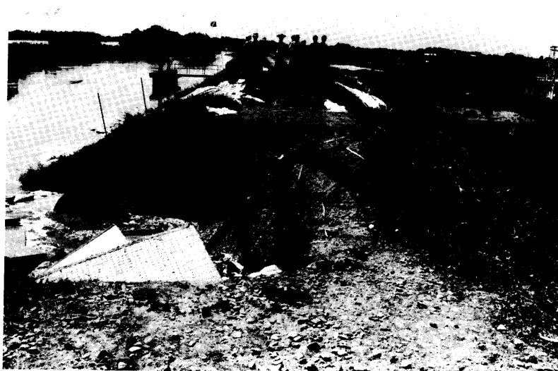
写真4.16 表法面の崩壊
