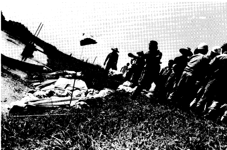
写真4.13 表法面への土のう積み
