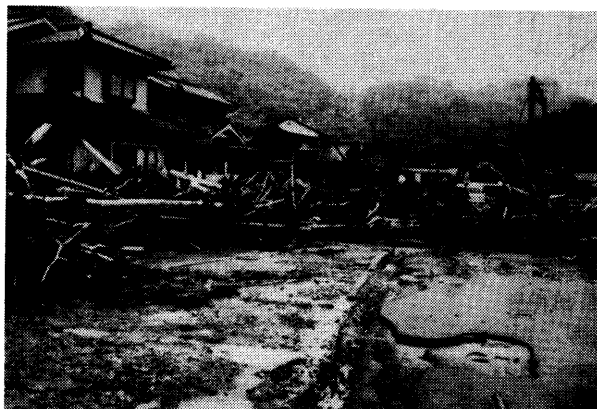
写真 3.7 流木が押し寄せた今井迫川付近の住家（相生町），浜田市提供
