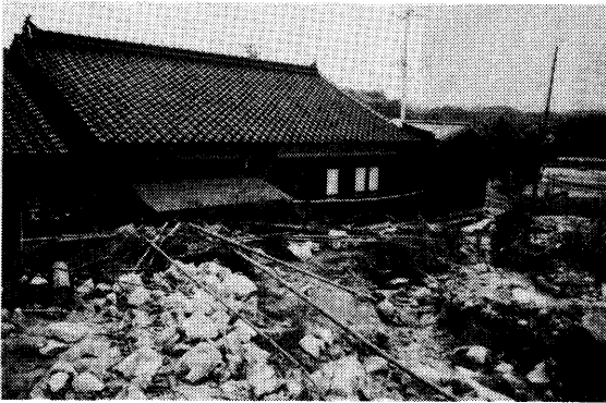
写真 4.4 花田川の土石流（浜田市佐野町）（浜田市提供）
