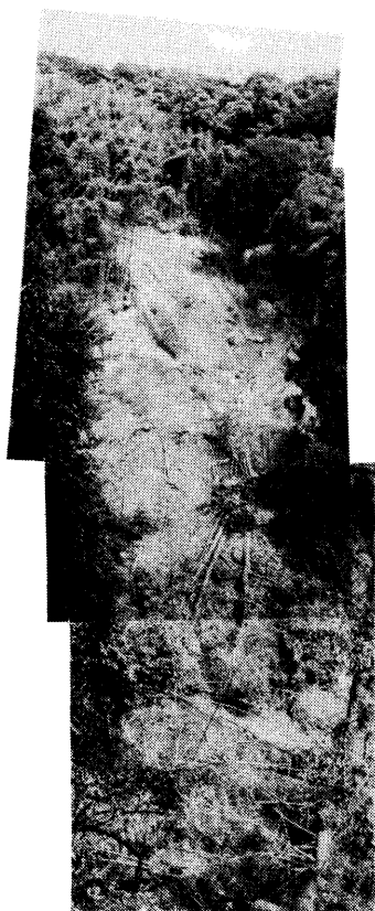
写真 4.14 今井迫川沿いの崩壊（急傾斜面の ため崩土は谷底まで落ちている）。
