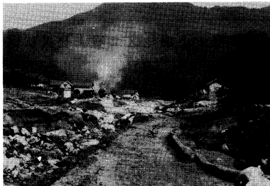
写真 4.25 加計町江河内地区の土石流の被災域
