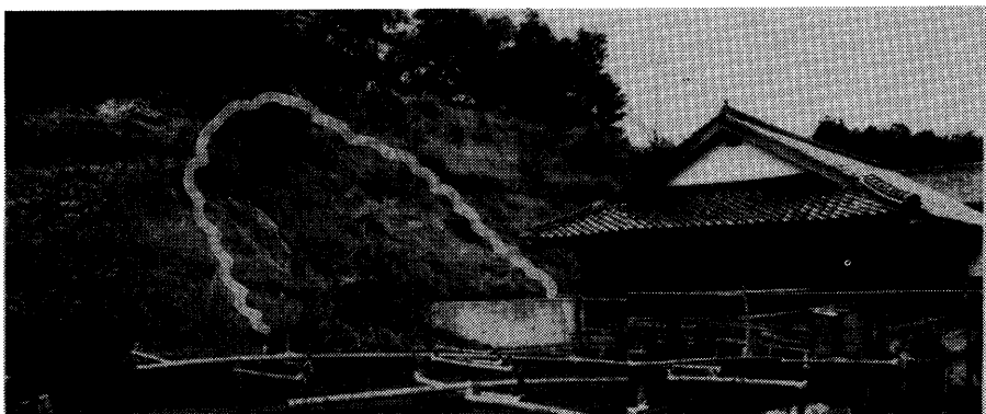
写真 4.9 岡本季芳氏宅裏の崩壊。土留工の末端付近での小崩壊（浜田市提供）
