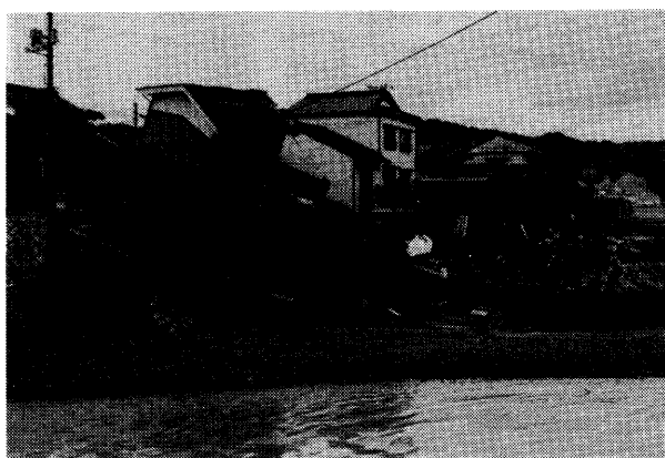
写真 3.11 氾濫水によって土台が削られた住家（上府町三宅地区），浜田市提供
