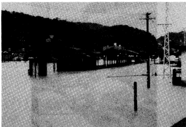
写真 3.3 浜田川支川浅井川の氾濫によるＪＲ浜田駅付近の浸水状況（浅井町），浜田市提供
