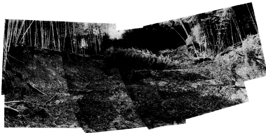
写真 4.13 三階町の崩壊（浸食小起伏面上のため厚い赤色土中での崩壊）
