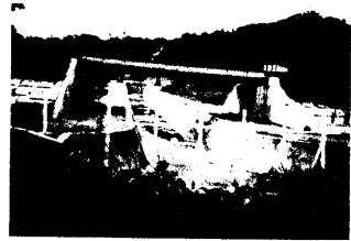
三隅川放水路
