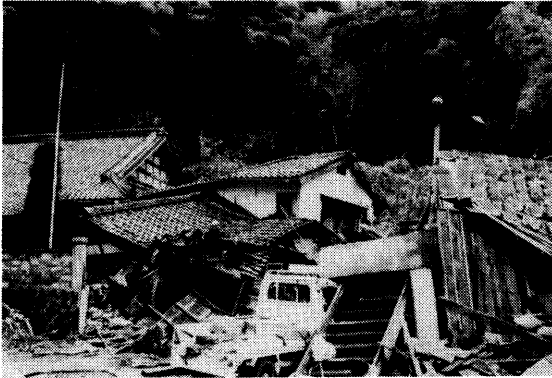
写真 4.3 裏山の崩壊により倒壊した 東亜アパート（浜田市相生 町）人的被害なし（浜田市 提供）
