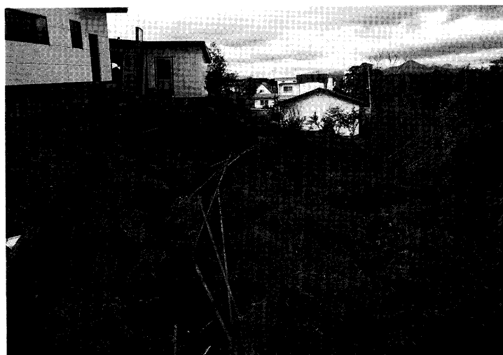
写真24 中標津住宅地すべりの南東端住宅の状況
