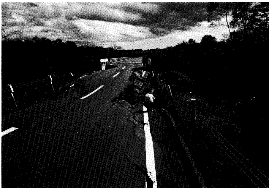
写真6 春別原野の美原地区北部付近橋アプローチ部被害 Photo 6 Bridge Approach Damages at Mihara North Area in Shunbetsu Wild Plain
