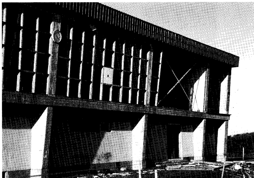
写真3 根室市光洋中学校体育館被害
