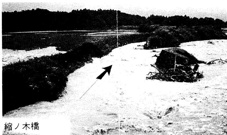
写真29 藤津川縮ノ木橋地点の破堤状況(金井町水害資料)。
