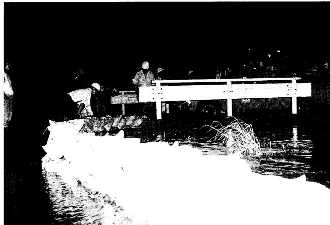
写真 22 水防工法 橋による堰あげ溢水を防ぐために土のうを積む（豊栄市提供）。
