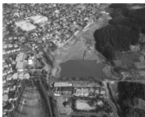
写真 12 名古屋市緑区の神沢池、灌漑用溜め池であり洪水の抑制機能を持っている（引用：愛知県，2000）。
