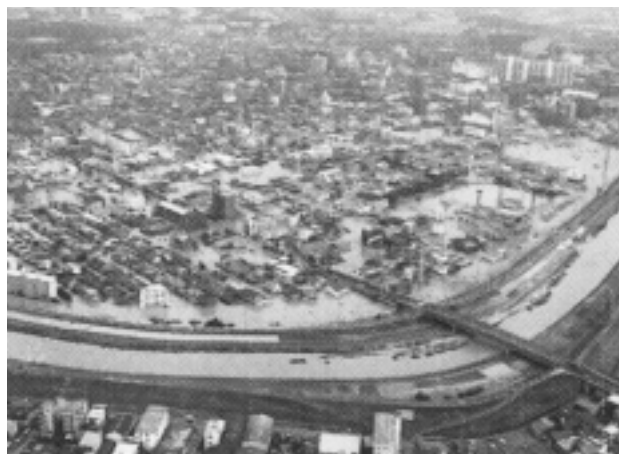
写真6 名古屋市天白区付近の天白川左岸の洪水氾濫状況、2000年9月12日撮影（提供：パスコ株式会社）
