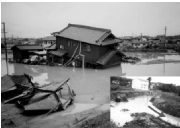
写真 14 洪水により破壊された民家、大府市で写真右端にある石ヶ瀬川の堤防が破堤し、そこから洪水が流れ込んだ（引用：愛知県，2000）。
