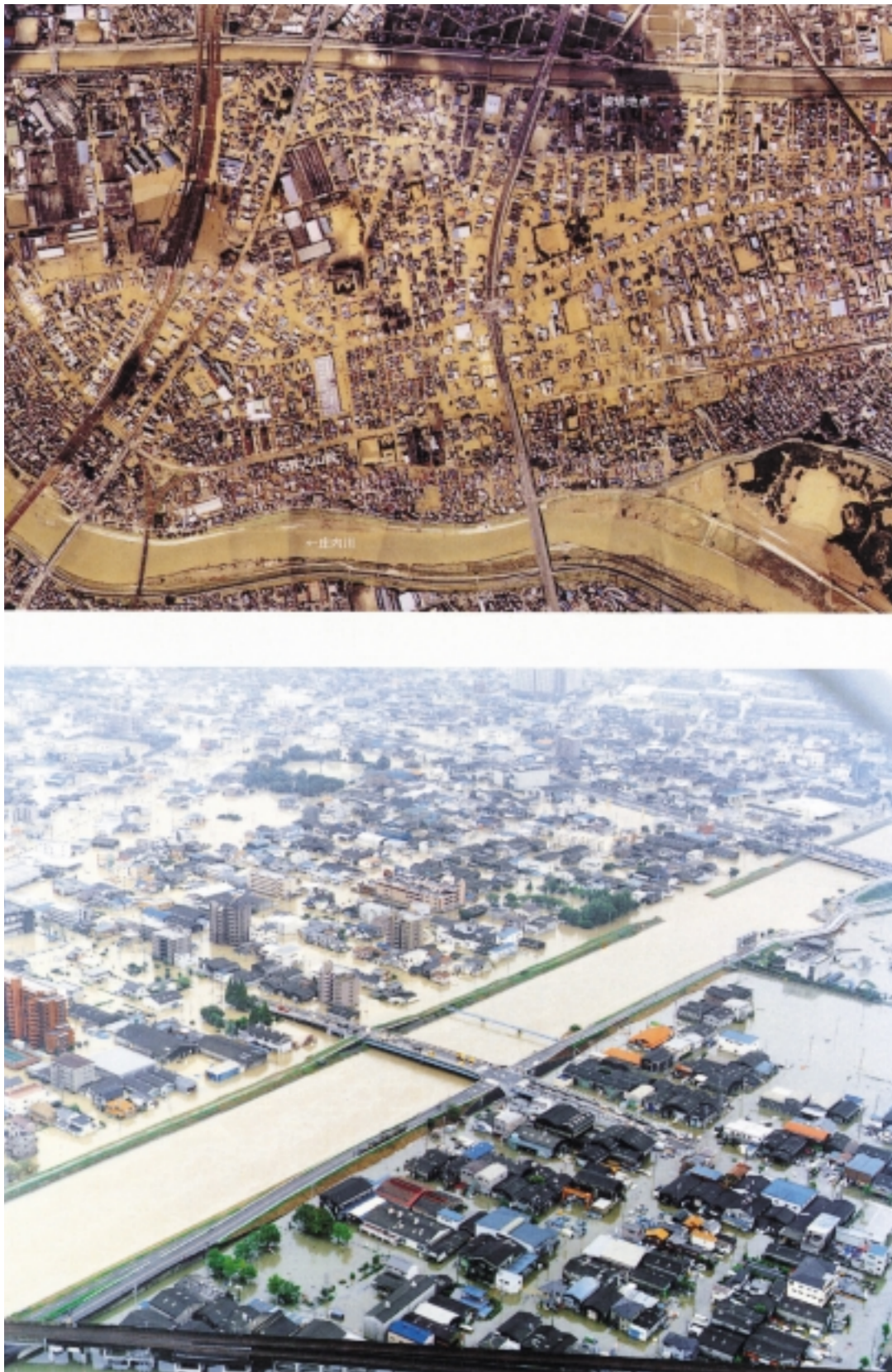
写真 14 (上) 新川破堤による浸水被害：新川（上）と庄内川（下）にはさまれた名古屋市西区，西枇杷島町が浸水した（愛知県提供）。 (下) 新川破堤地点浸水状況（パスコ（株）提供）
