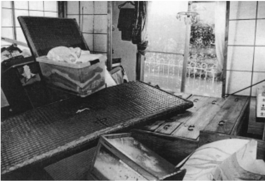
写真 6 浸水家屋の被災状況：西枇杷島町小田井付近（蒲池氏提供）
