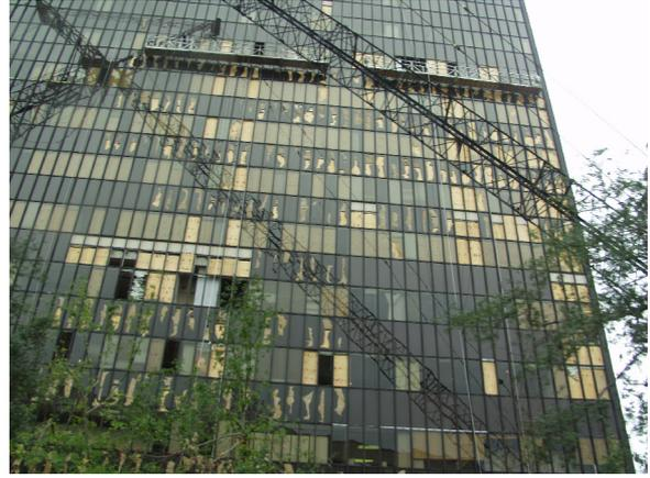
写真 3.2 風害：高層ビルの窓ガラス被害
