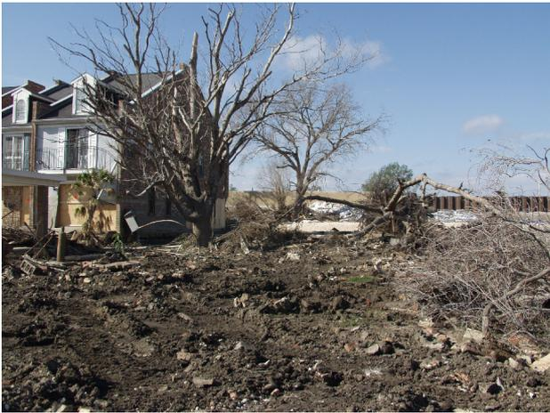
写真 6.2 17th St. Canal 堤防破堤地点の被害
