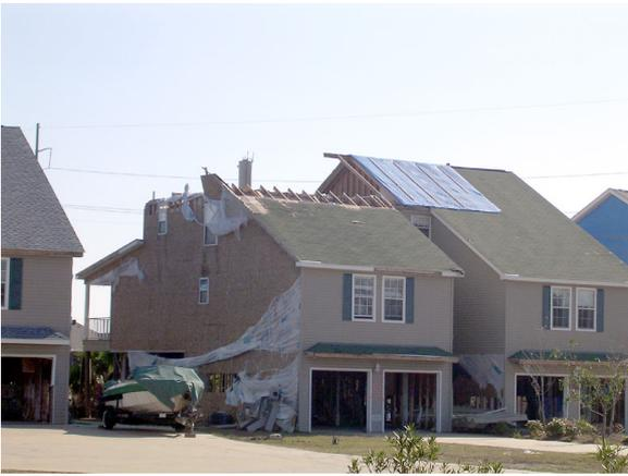
写真 3.3 風害：住宅の被害
