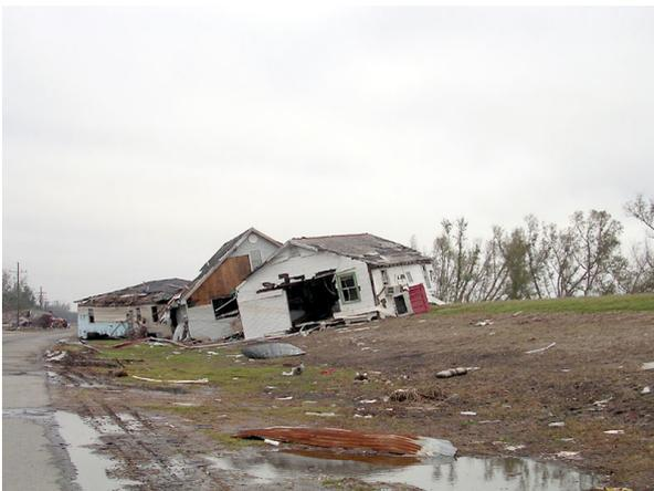
写真 4.2 プラクミン地区：高潮に流されミシシッピ川の堤防に押し上げられた住宅
