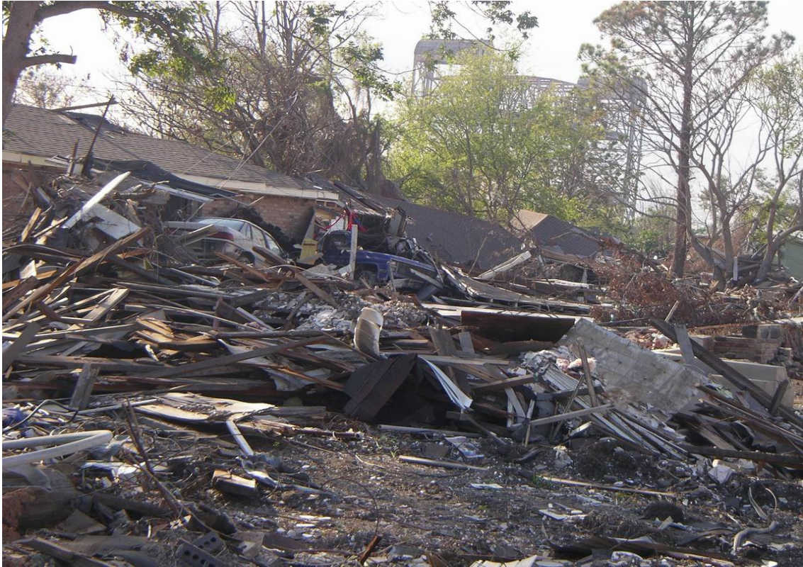
写真 1 Inner Harbor Navigation Canal の破堤箇所の写真。隣接する住宅地（Lower Ninth Ward 地区）、とくに破堤地点周辺では、住宅の倒壊や流動が見られる（2005 年 12 月 1 日撮影）。
