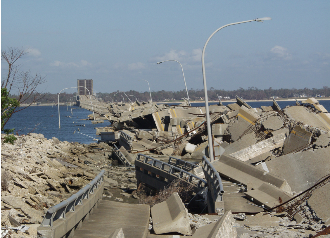
写真 9 ミシガン州 Biloxi 市の落橋 (2005 年 12 月 3 日撮影) Photo 9 Collapse of bridge in Biloxi City, Mississippi State.
