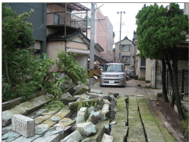
写真3 崩壊した石塀 Photo 3 Collapsed stone fence.
