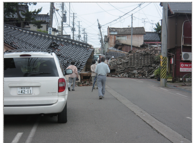
写真2 倒壊して道路にはみ出した住宅
