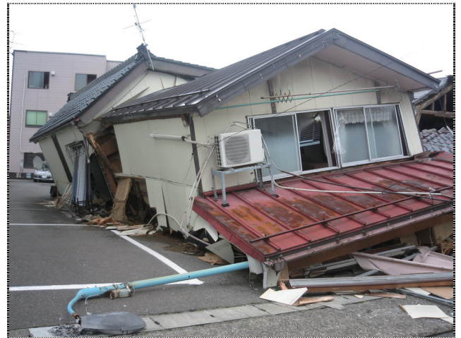
写真1 柏崎市中心街の倒壊家屋
