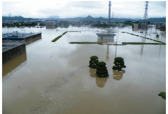
図10 朝田浄水場の浸水状況
