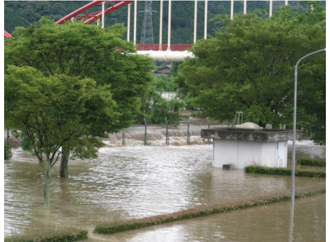
図9 朝田浄水場の浸水状況
