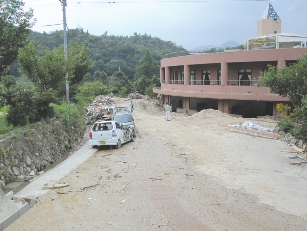
写真4 建物背後から土砂の流下方向を見る。 Photo 4 The view from the backyard of the main building.
