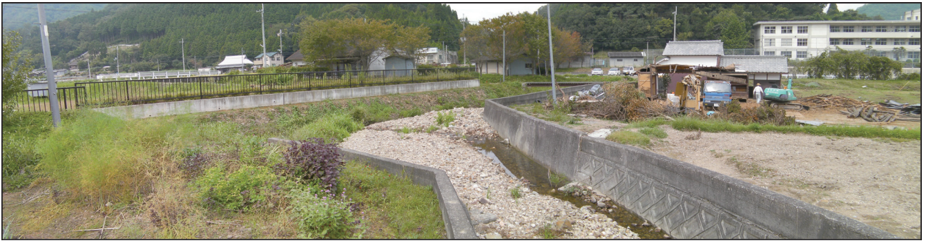
写真 13 幕山川に南側から流入する水路。合流部付近の住宅が被災し、取り壊されている。 Photo 13 Southern branch of the Makuyama river. The junction point flooded and destroyed a house.
