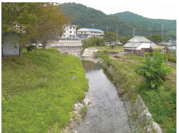
写真12 水が溢れた幕山川(中央に見える丸屋根の建物は住民が避難しようとした幕山小学校) Photo12 Makuyama river had overflowed. The dome-topped building is Makuyama elementary school (evacuation shelter).
