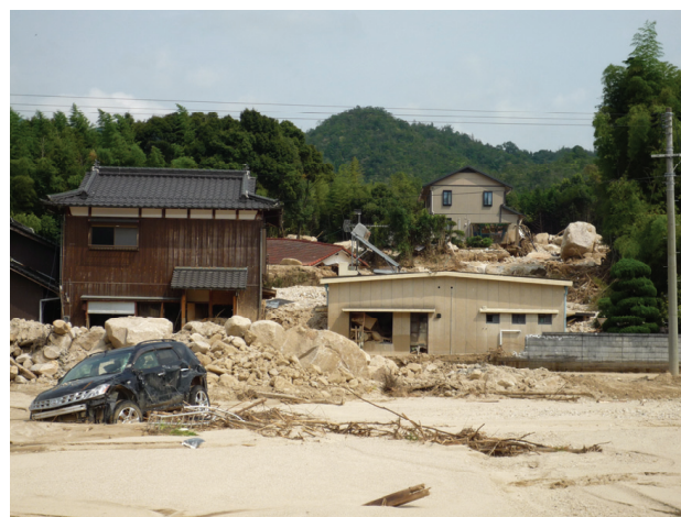
写真 5 下郷の被害状況(筆者撮影) Photo 5 The damage situation of Shimogou.
