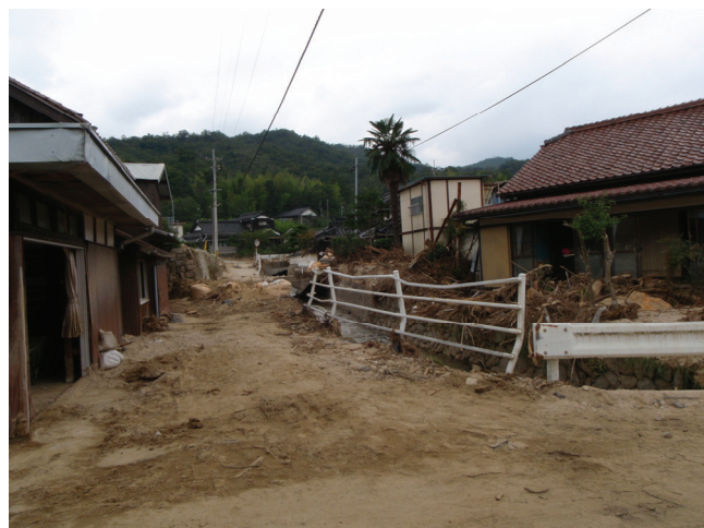
写真 2 奈美の被害状況 (若月強氏 撮影) Photo 2 The damage situation of Nami.
