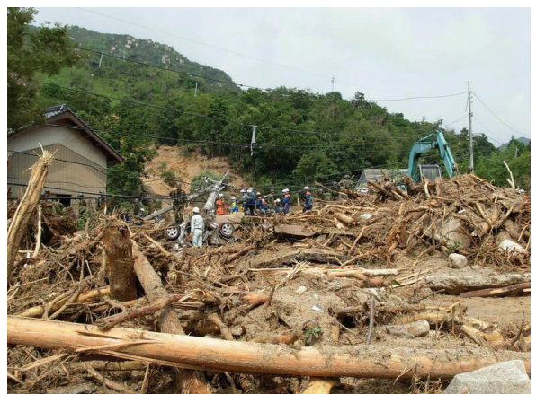
写真4 勝坂の被害状況(山口県広報広聴課 HP より)
