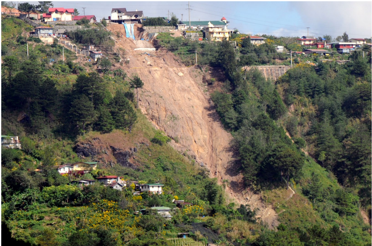
口絵 3 バギオ市郊外での土砂災害発生斜面の状況（撮影：井口 隆）
