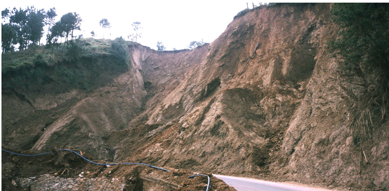
口絵 6 リトルキブンガンで発生した地すべりの発生源（右側方崖は断層面） Fig. 6 Source of the Little Kibungan landslide.
