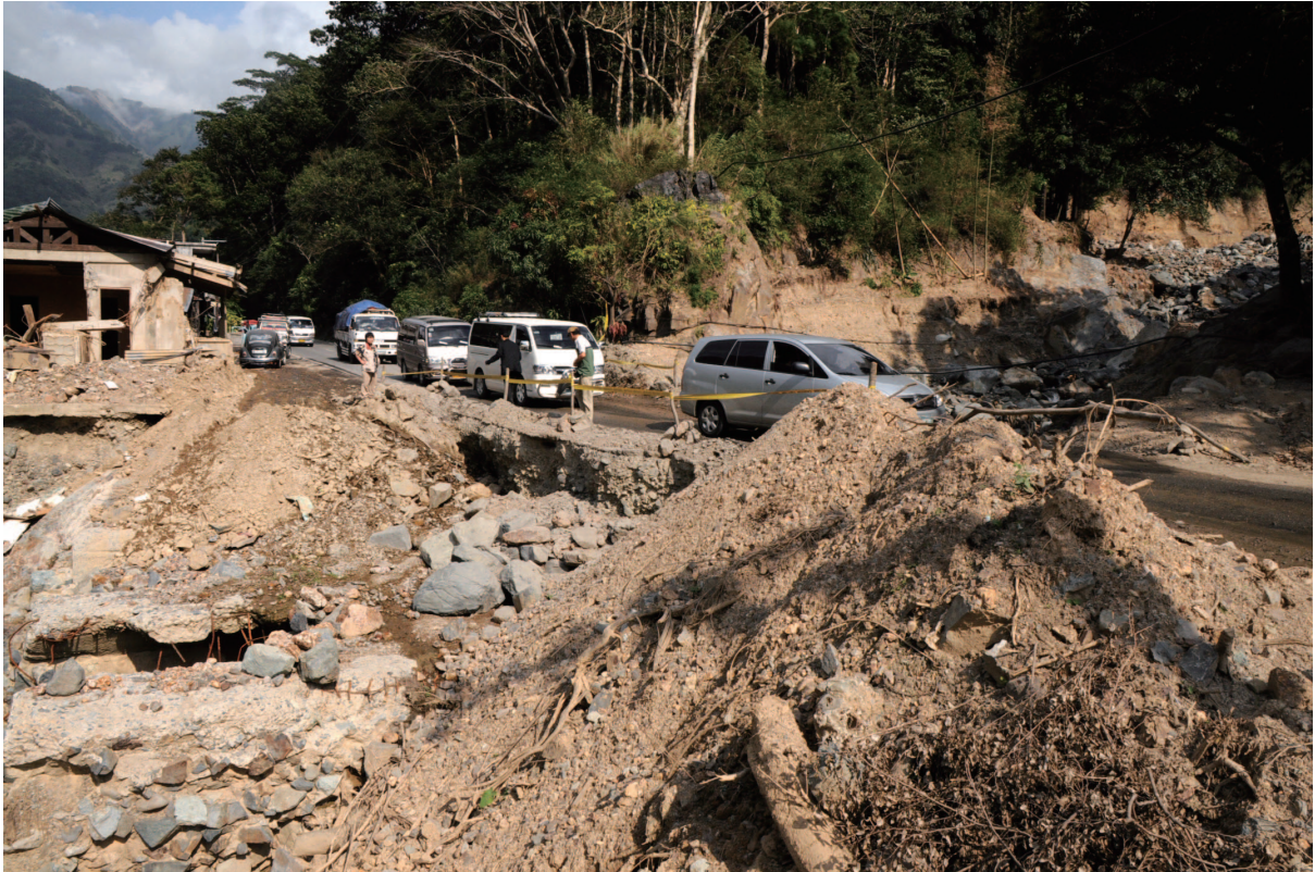
口絵 7 Kennon Road 沿いの渓流から流下した土石流で被災した家屋と道路 Fig. 7 Damaged house and road hit by debris flow on Kennon Road.
