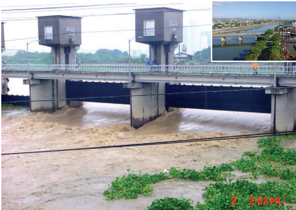
口絵 12 マリキナ川の洪水をラグナ湖へと分流するマンガハン洪水放水路の取水口・ロザリオ水門
