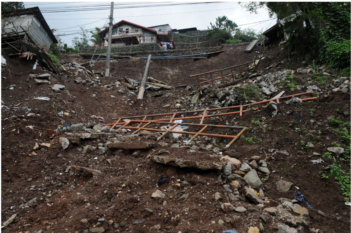
口絵 2 バギオ市 Cresencia Village の道路脇の斜面で起きた土砂崩れ（撮影：井口 隆）
