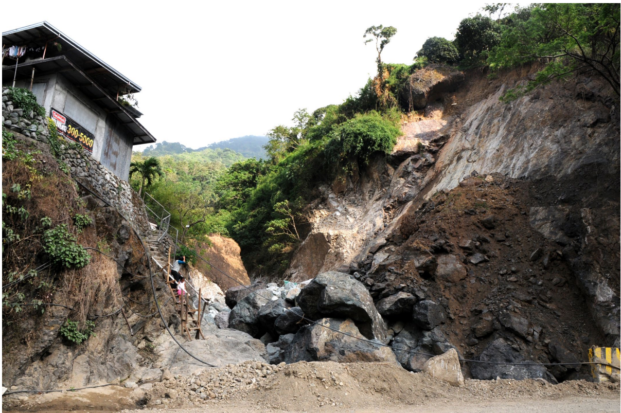
口絵 8 Kennon Road 沿いで発生した岩崩れ現場 Fig. 8 Rock slide on Kennon Road.
